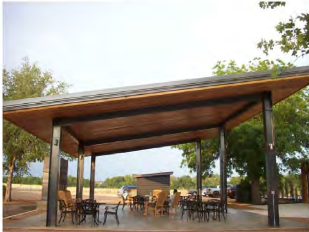
WJ/ KK SHADE PAVILLIONS (VARIOUS SIZES) SCALE: N.T.S. *not UF LMP standard
